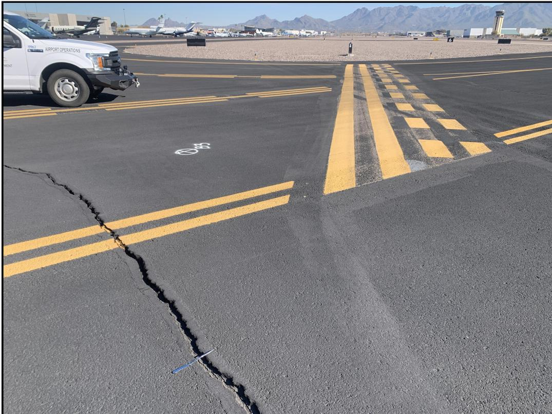
TRANSVERSE CRACKING FROM TAXIWAY SHOULDER TO CENTER OF TAXIWAY CONNECTOR
