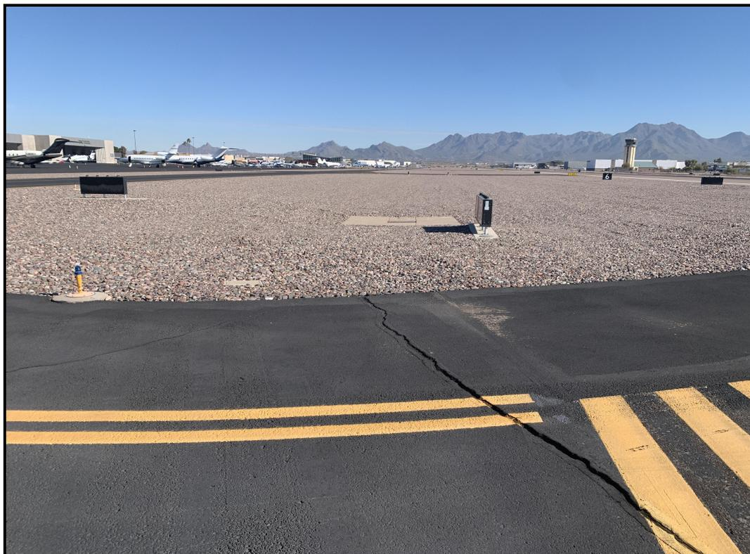
**TRANSVERSE CRACKING PERPENDICULAR TO THE TAXIWAY SHOULDER EDGE**
